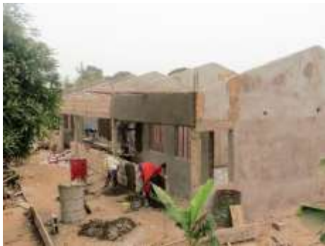
Het plamuren van het gebouw
