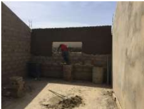
Het plamuren van de binnenkant
