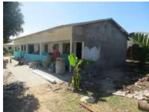
Het verven is gestart
