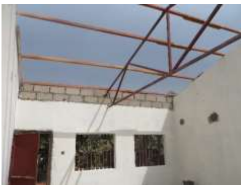
Het plaatsen van het dak frame
